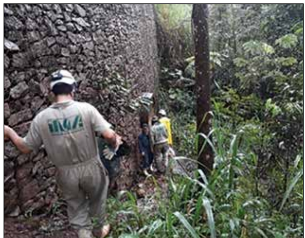
Foto 12: inspeção em bueiro sob a ferrovia MRS.
